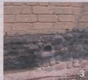
1. Лаком покрыла все в два слоя. 2. На реке набрала плоских камней. 3. Грубой щеткой убрала цементную пыль и песок. Фото нашей читательницы Л. Райхерт
